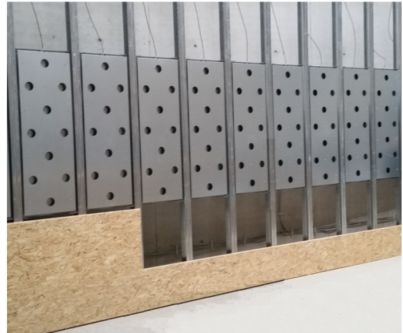
Beplankung des Ständerwerks mit OSB Platten
