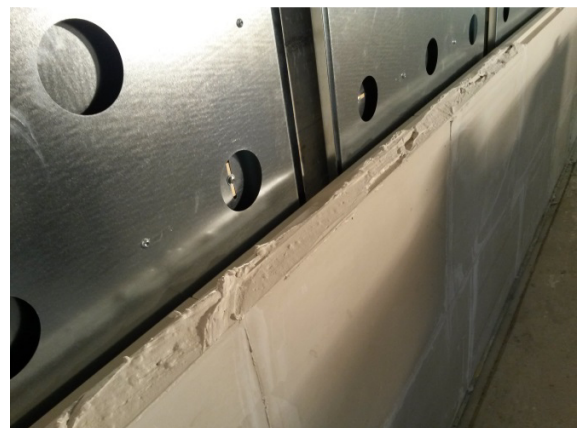
Vollgipsplatte vor Sensorfläche, halb fertig
