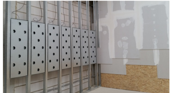
Offene und mit OSB / Rigips beplankte Wand
