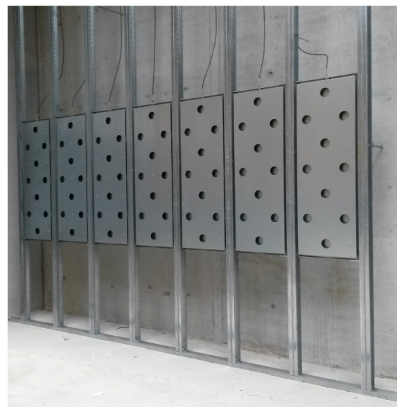
Sensorflächen im Ständerwerk, Raster 625mm
